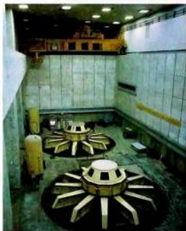
Токтогул ГЭСинин трубиналары.
